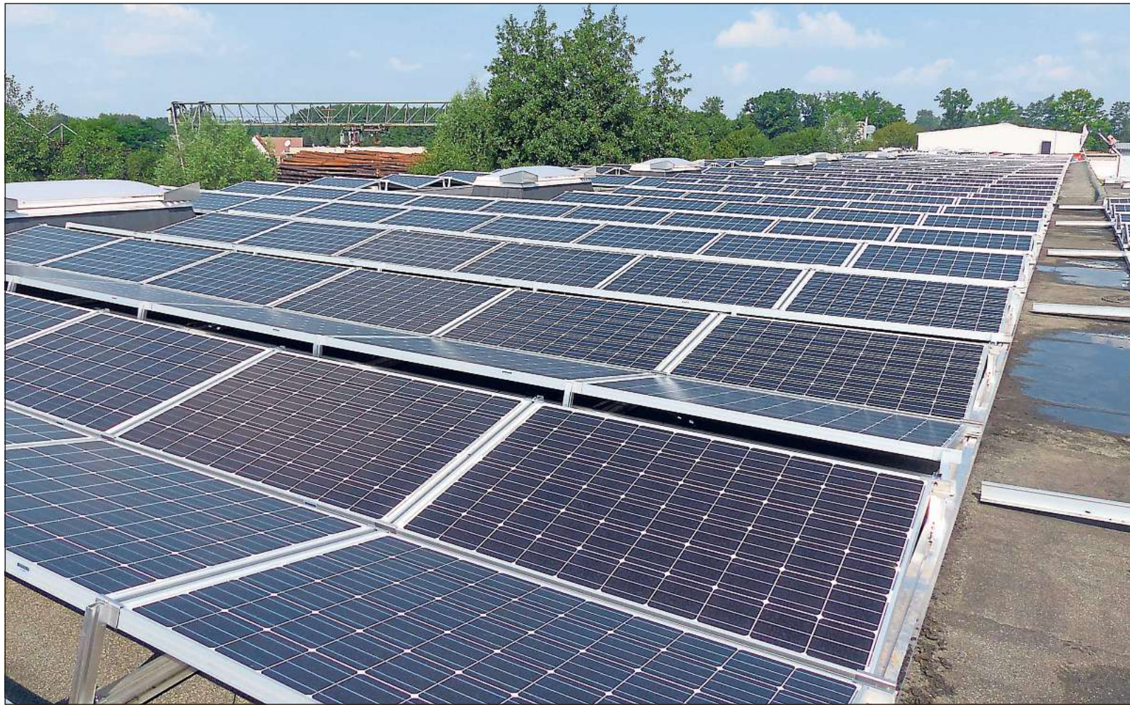
Ein Stück weit unabhängig von steigenden Energiepreisen macht sich die Firma Josef Henkenjohann am Kapellenweg in Kaunitz. 300 000 Euro wurden in eine Photovoltaikanlage investiert. Mit dem Neubau einer Halle sollen weitere Elemente installiert werden.
